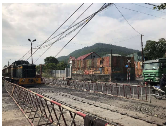
Hình ảnh bản đường ngang dự ứng lực trong quá trình khai thác sử dụng.
