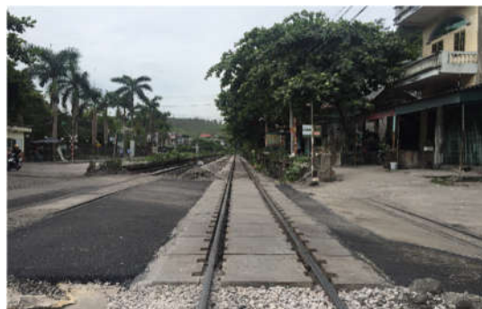
Bản bê tông dự ứng lực lắp đặt tại đường vào mỏ than Mông Dương - Cẩm Phả - Quảng Ninh.
