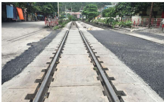
Bản bê tông dự ứng lực lắp đặt tại đường vào mỏ than Mông Dương - Cẩm Phả - Quảng Ninh.
